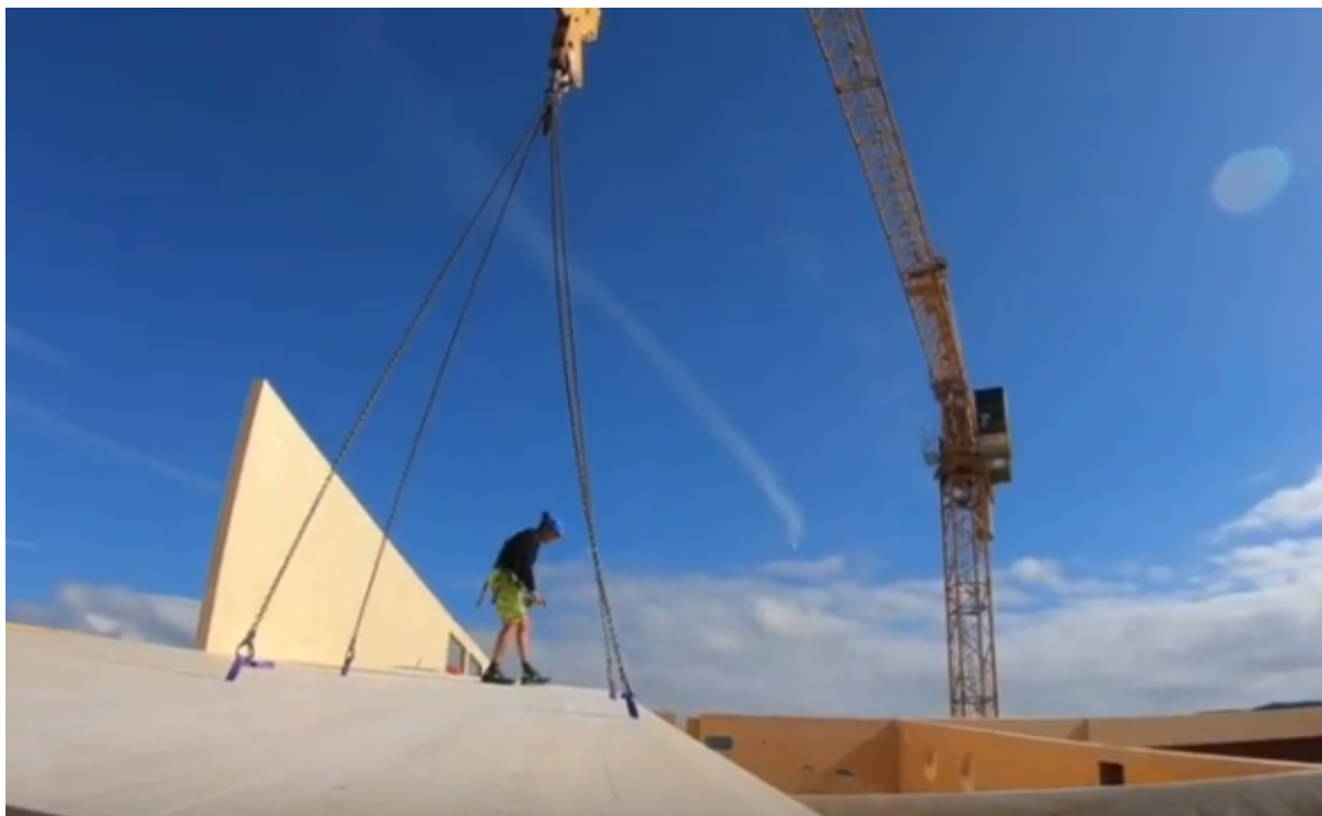
Bilde: Bygging av skole med dekker i krysslimt tre, Sauherad barneskole i Telemark (Foto: Kristin Vedum)
